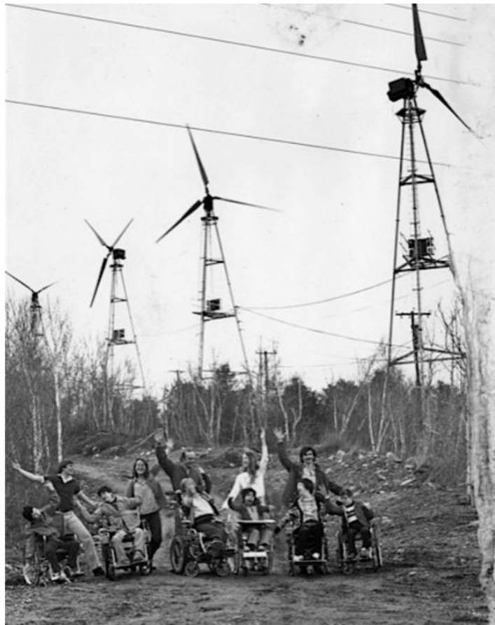
1er parc eòlic (1980), Crotched Mountain (NH), 20 aerogeneradors de 30 kW de US Windpower
