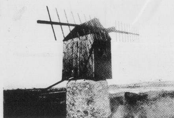
Figura 39. Molino de pivote que se encuentra en la isla de Ouessant (Bretaña francesa).
