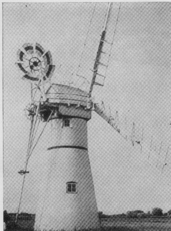
Figura 49. Dispositivo automático de orientación.
