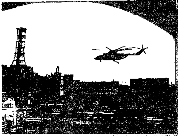
La desactivación total de los edificios de la central fue realizada tres meses después del accidente
